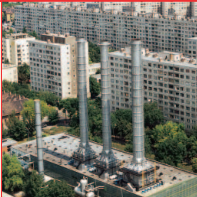
A bezárásra kerülő Zapor utcai fűtőmű
