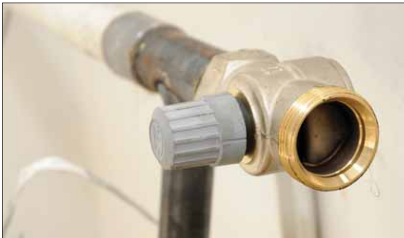
Beépített radiátorszelep
