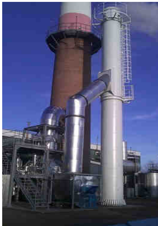
1. kép – Füstgáz hőhasznosító
