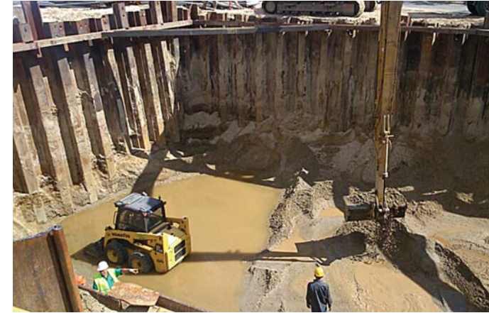
A szivattyúház teljes egészében a föld alatt került elhelyezésre
