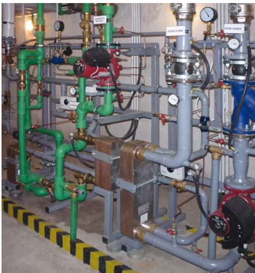
Távfelügyelettel ellátott felhasználói hőközpont
