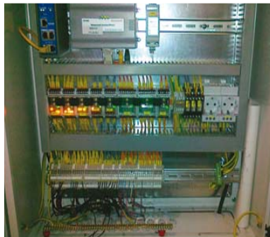
Távfelügyeleti rendszerbe integrált hőközpont és vezérlőszekrény
