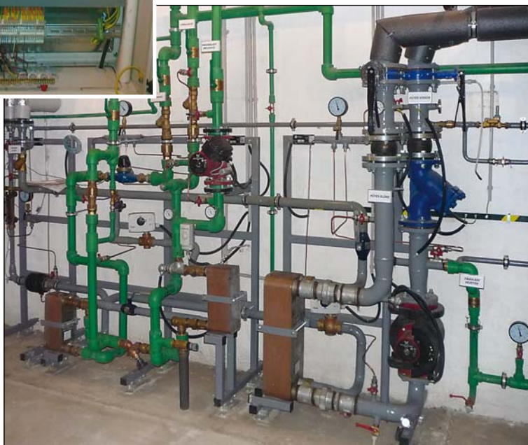
Távfelügyeleti rendszerbe integrált hőközpont és vezérlőszekrény
